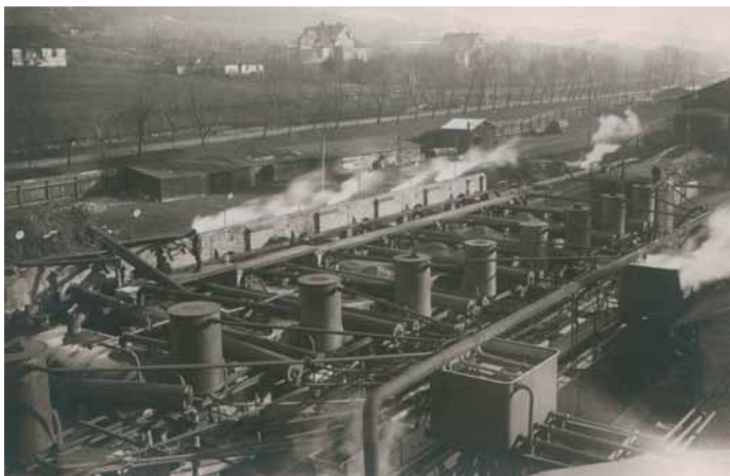
Rafineria Nafty w Sowlinach k. Limanowej, ze zbiorów Archiwum Narodowego w Krakowie.
