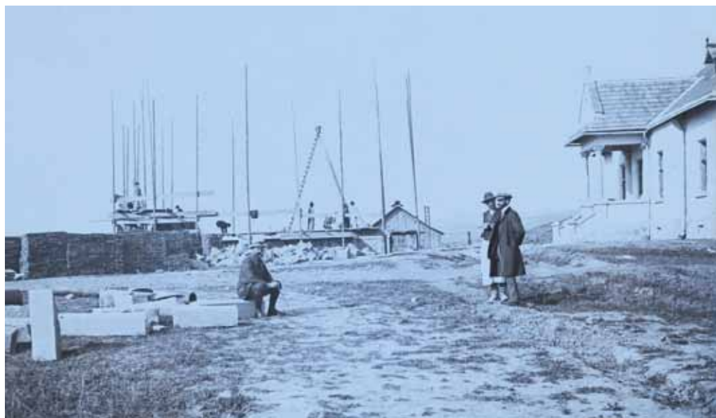
Budowa zakładu pomp w Świniarsku w 1911 r., ze zbiorów Archiwum Narodowego w Krakowie Oddział w Nowym Sączu.
