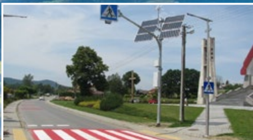
MODERNIZACJA I PRZEBUDOWA DRÓG POWIATOWYCH ORAZ PRZEJŚĆ DLA PIESZYCH
