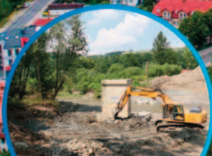
Budowa mostu w ciągu ul. Dudka
