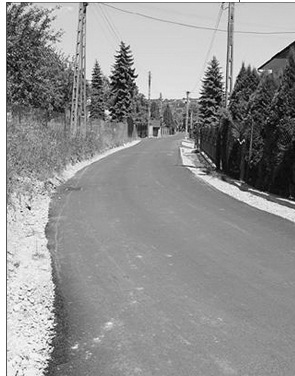
Budowa kanalizacji burzowej
