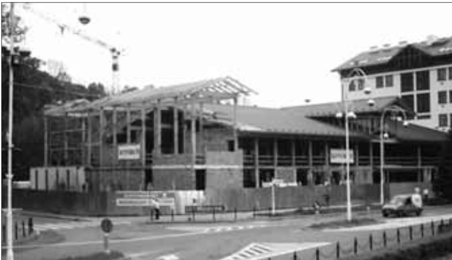
Budowa galerii R. Kluski w Krynicy-Zdroju
