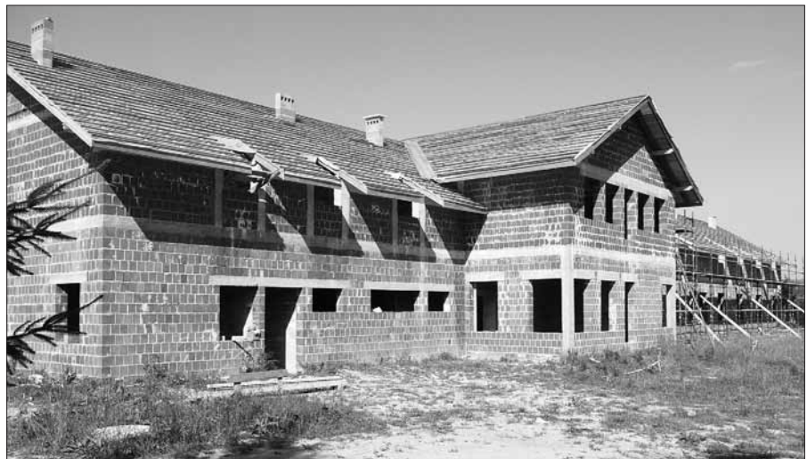
Budowa hospicjum FOT. ROMAN PORĘBSKI
