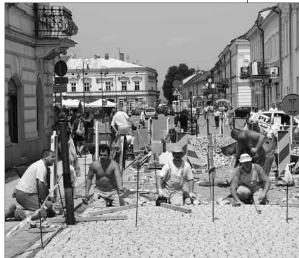
Remont ul. Jagiellońskiej FOT. LES
