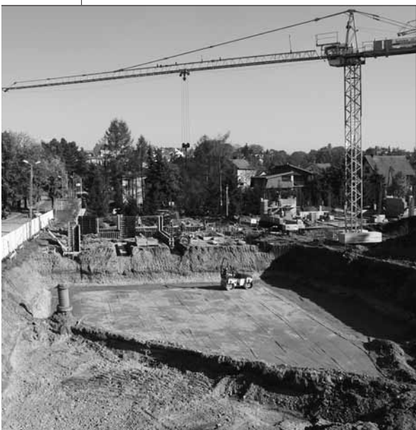
Sportowa akademія – budowa
