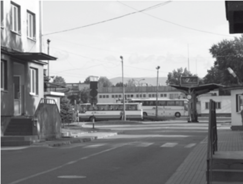
Baza PKS przy ul. Wyspiańskiego, tu miałby być nowy dworzec
