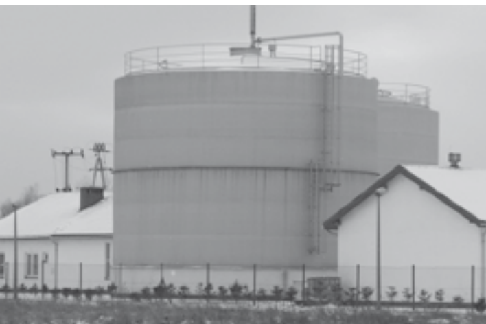
Oczyszczalnia w Podrzeczu. Fot. arch. UG Podegrodzie
