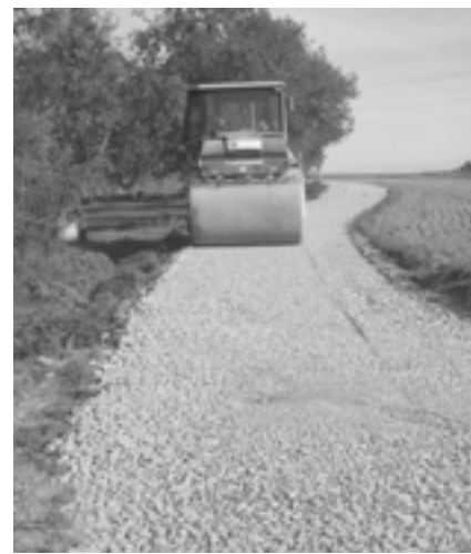
Budowa drogi w Długołęce – Świerkli. Fot. arch. UG Podegrodzie
