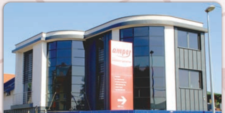
Do nowego obiektu zostanie przeniesiona hurtownia, a firma powiększy usługi o prefabrykację rozdzielnic na potrzeby energetyki i elektrotechniki
