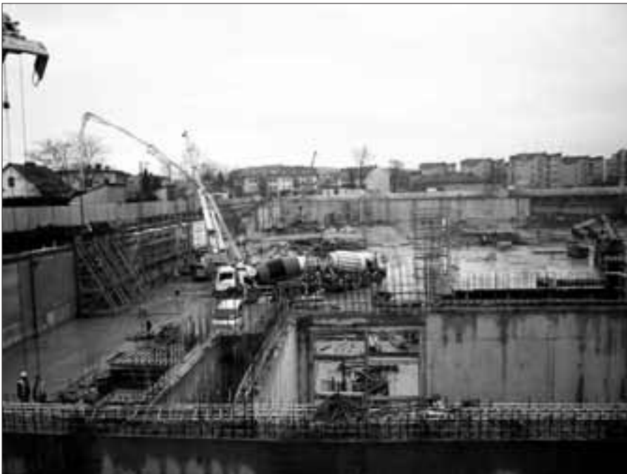
Budowa galerii „Trzy korony” przy ul. Lwowskiej FOT. MIKOŁAJ WAŃCZYK
