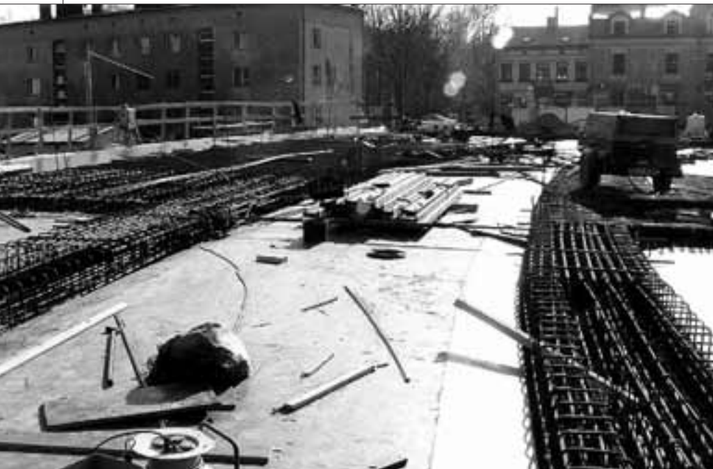
Budowa mostu w Grybowie
