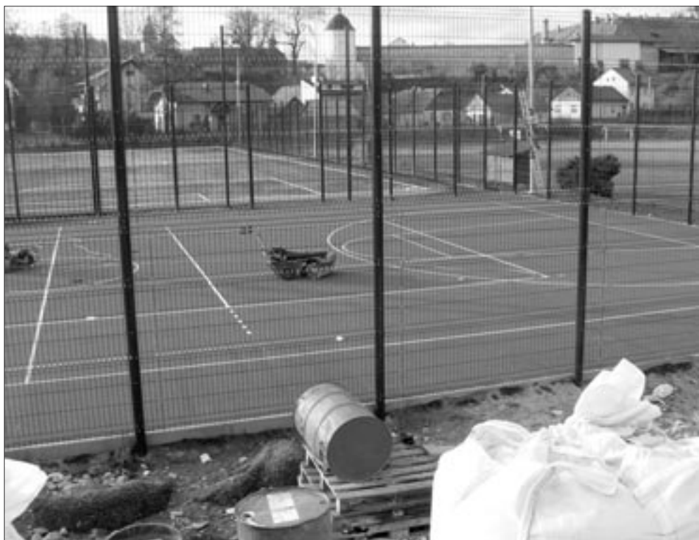
Budowa starosądeckiego „Orlika”
