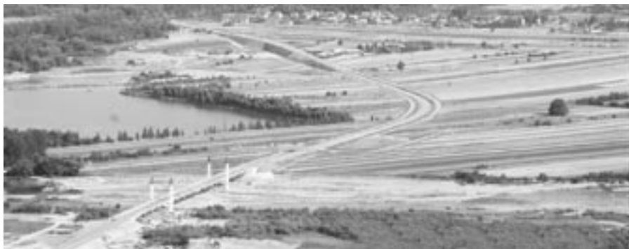
Obejście drogowe Starego i Nowego Sącza wraz z mostem na Dunajcu
