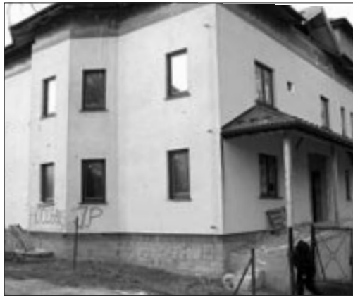
Na wykończeniu jest budowa domu opieki społecznej w Białej Niżnej
