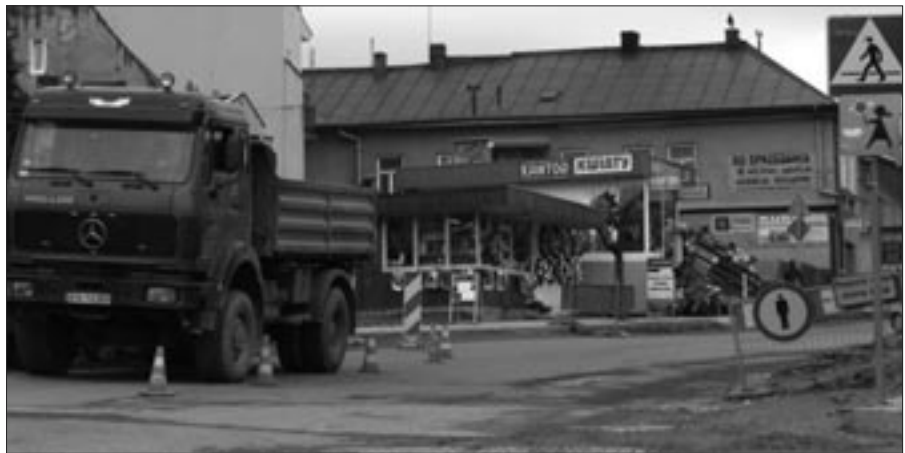
Prace przy modernizacji drogi krajowej nr 28 na rynku grybowskim
