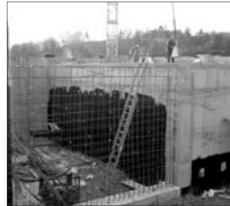
Potężne silosy oczyszczalni ścieków w Stróżach są już gotowe
