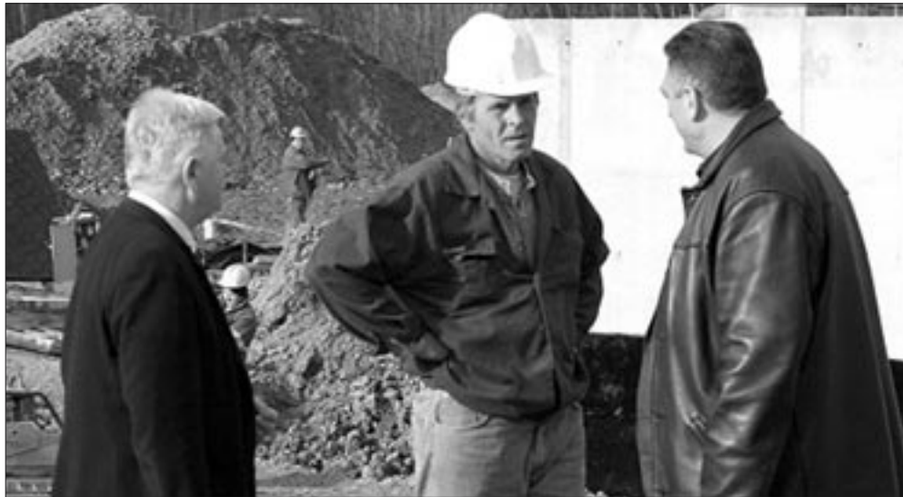
Gospodarska narada na budowie oczyszczalni ścieków w Stróżach
