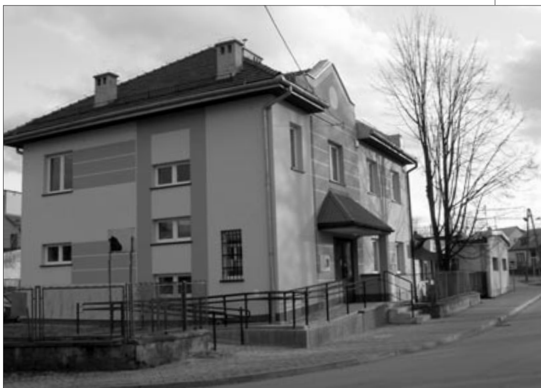
Budynek przy ul. Krakowskiej
