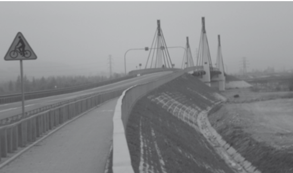
Nowy most przez Dunajec na trasie obwodnicy Starego Sącza
