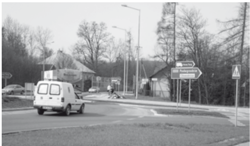
Rondo u wjazdu do Starego Sącza z wjazdem na obwodnicę
